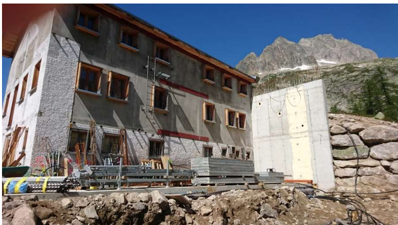
16 luglio 2019 – Muro sostegno lato est
